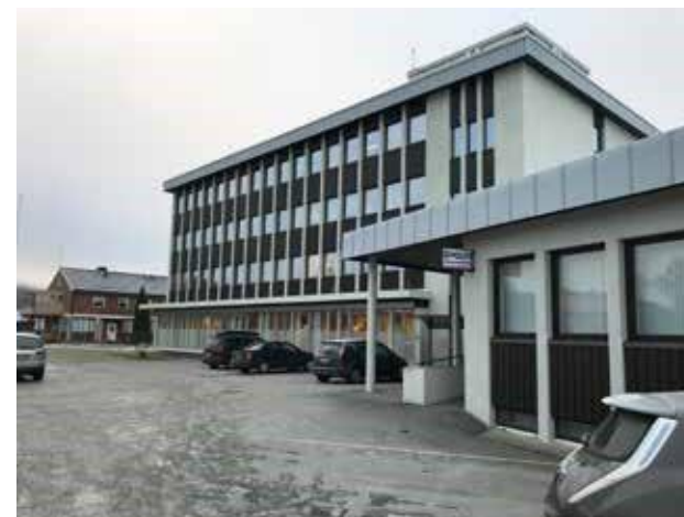
47 Kommunehuset i Overhalla, 2017.
