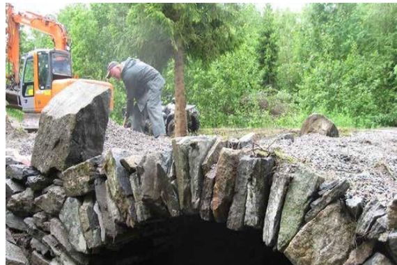
17 Restaurering av Selotten bru, 2008.
