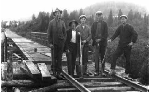
12 Arbeid med Namsosbanen ved Reina bru, 1930.
