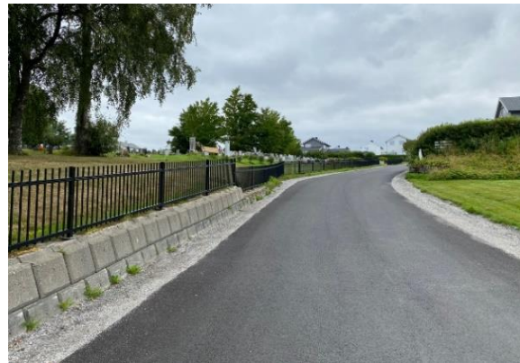
Nytt gjerde og asfalt
