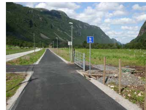
Dirdal - Gilja, Statens vegvesen, 2011
